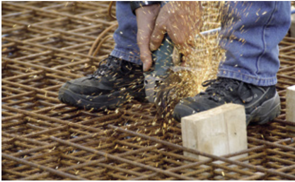
Verschweißen von Betonstahlmatten, „Skulpturen am Fluss“
